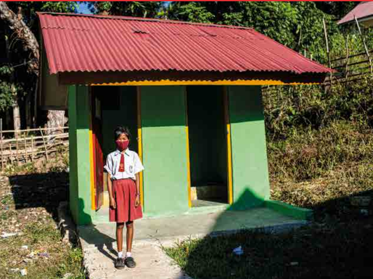
Kondisi toilet SDN di Sumba Barat pasca rehab
