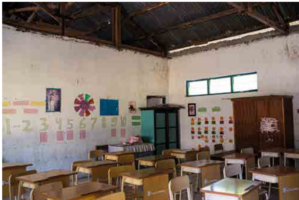
Ruang Kelas SDN di Sumba Barat sebelum rehab
